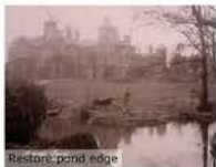
Restore pond edge
